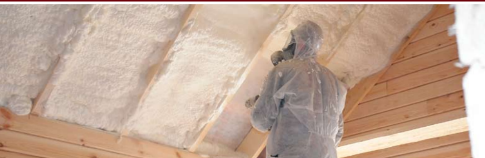
Теплоизоляция ППУ стен и кровли загородного дома
