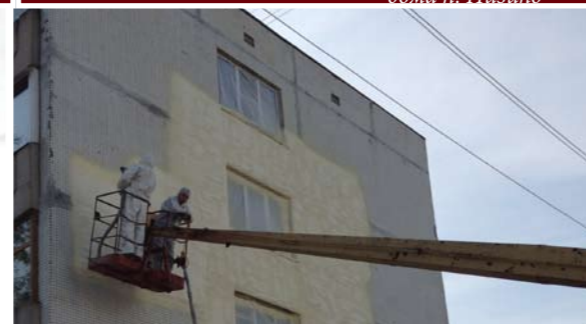
Утепление ППУ стен муниципального дома п. Низино
