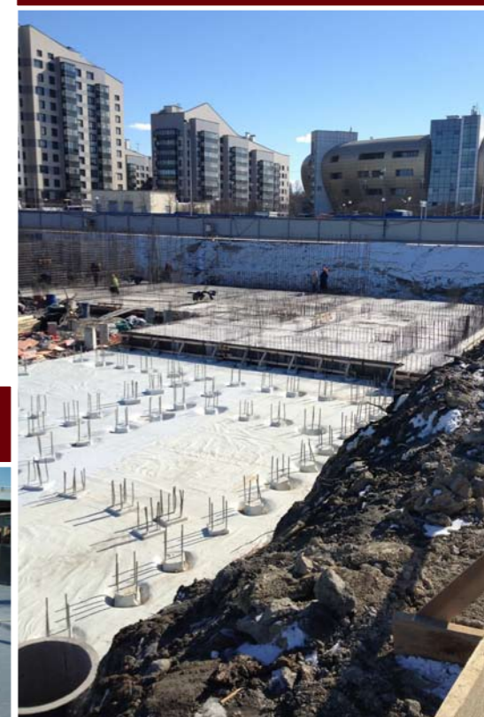
Гидроизоляция полимочевиной фундамента ЖК Балтийская Жемчужина
