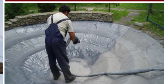
Гидроизоляция полимочевиной декоративного пруда
