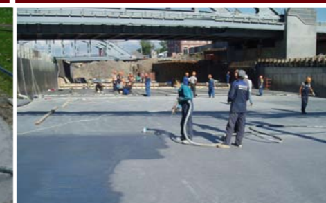
Гидроизоляция полимочевиной автодорожного тоннеля Обводный канал
